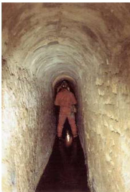
Figura 10 - Tratto dell'acquedotto di Faicchio con pareti in muratura e volta a tutto sesto (foto S. Capasso, da Caiazza, 1997).
