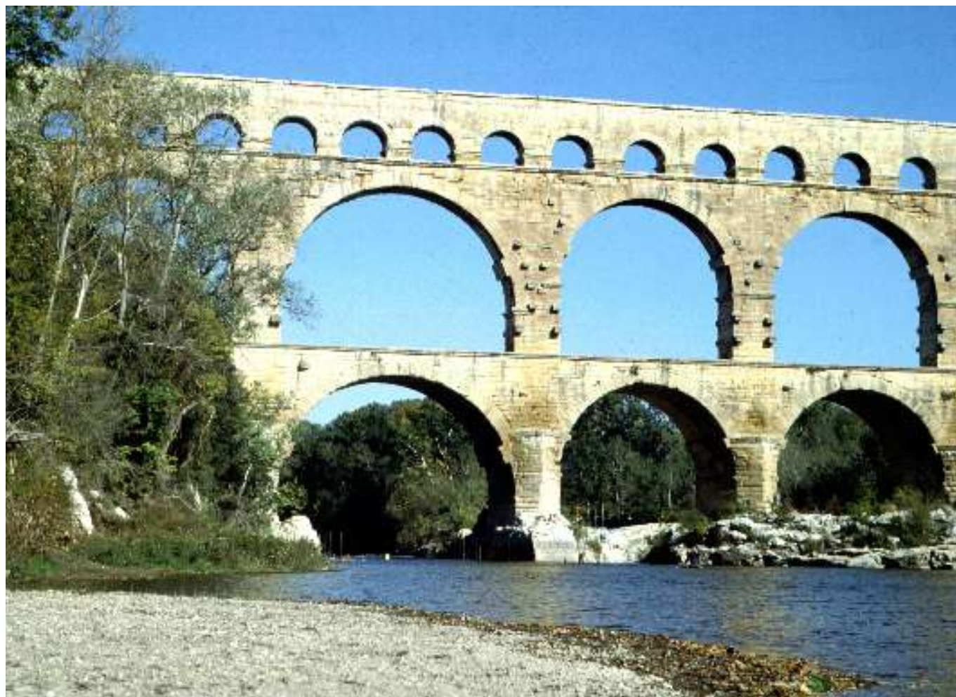
Figura 2: le arcate del Pont du Gard, in Francia, famoso non solo per la sua bellezza, ma anche per le sue dimensioni (275 m di lunghezza per 49 di altezza). Il ponte scavalca la valle del fiume Gard ed era parte integrante dell'acquedotto di Nîmes (Foto Carlo Germani).
