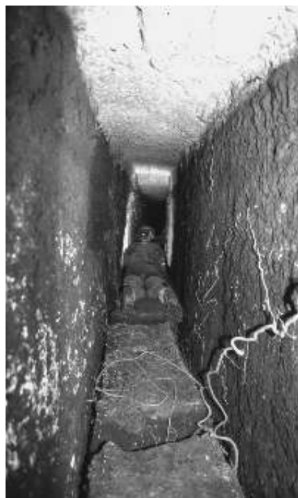
Specus a sezione rettangolare del ramo sud dell'acquedotto romano di Carales (Cagliari).
