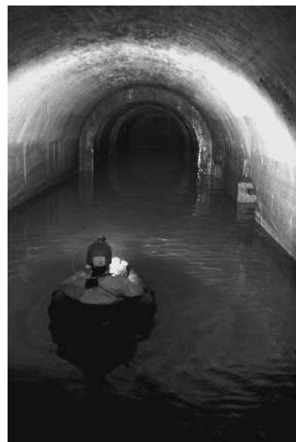
Ancona, Cisterna settecentesca di Piazza Cavour.
