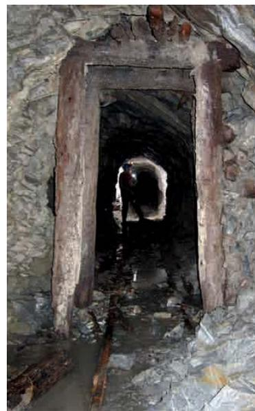
Figura 9 - Miniera bassa, travi di sostegno nella galleria Costanza.
