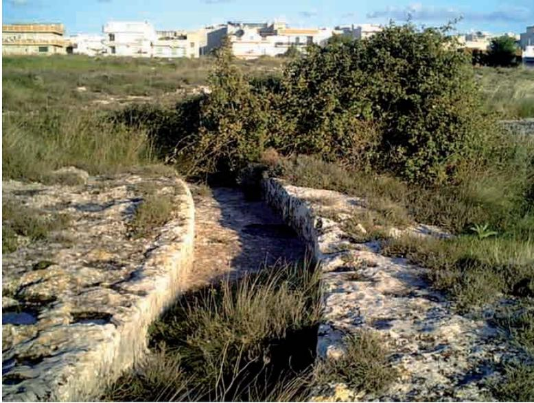
Figura 6 - Canalizzazione per la raccolta dell'acqua piovana.
