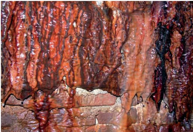
Figura 4 – Visione generale del concrezionamento sviluppatosi al di sopra di un muro di tamponamento costruito durante i lavori di riadattamento funzionale dell'acquedotto terminati nel 1881: al centro in basso sono evidenti i mattoni utilizzati nel 1880.
