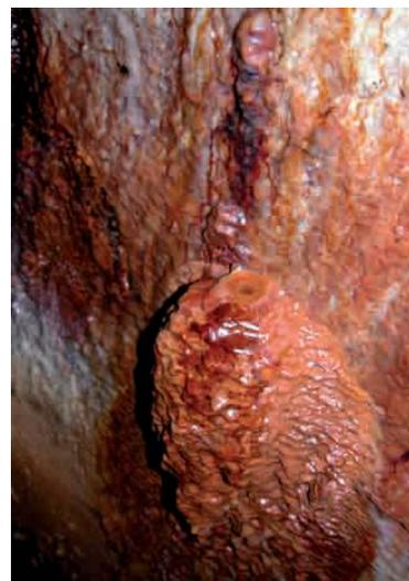
Figura 1 - Particolare di una antistalattite dell'Acquedotto Romano della Val di Setta: è evidente l'ampio foro di alimentazione e la struttura parietale a microgour.
