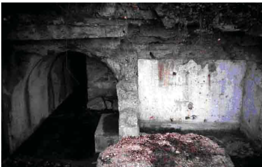
Foto 2: l'area dell'ingresso dell'ipogeo, con i resti della postazione di mitragliatrice e la vasca alimentata dalla fonte interna. Si noti il muro antisoffio all'ingresso della galleria.
