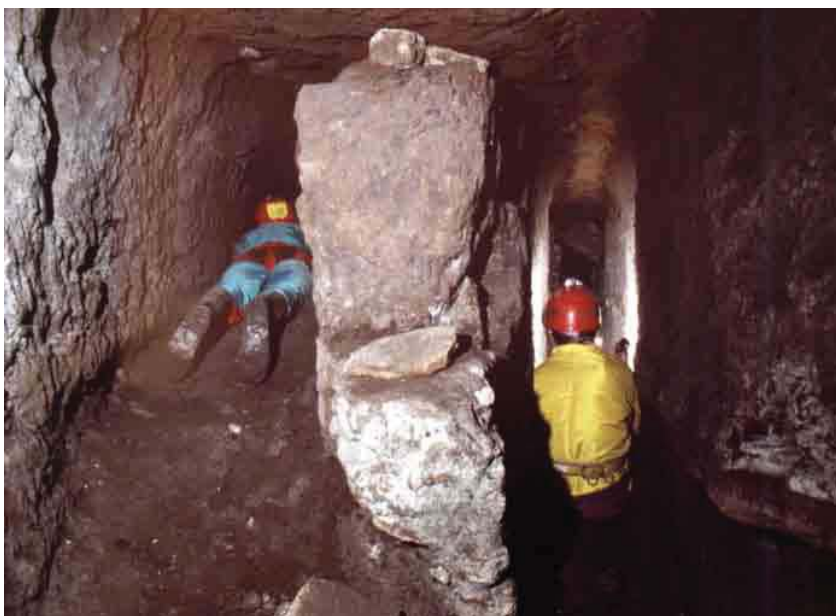
Foto 11 e 12 (dall'alto): la frana che chiude a valle il cunicolo sotto la chiesa di S. Maria (foto ASSO); incrocio di cunicoli sotto la Cappella Farnesiana (foto C. Germani).
