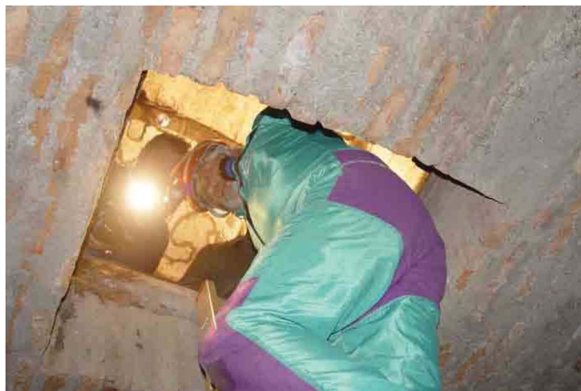
Foto 8,9 e 10 (dall'alto): la delicata fase della discesa nel pozzo sotto il Coro (foto C. Germani); il pozzo di 8 metri sotto il Coro (foto C. Germani); discesa nel sepolcretto della Cripta Ferrata (foto ASSO).
