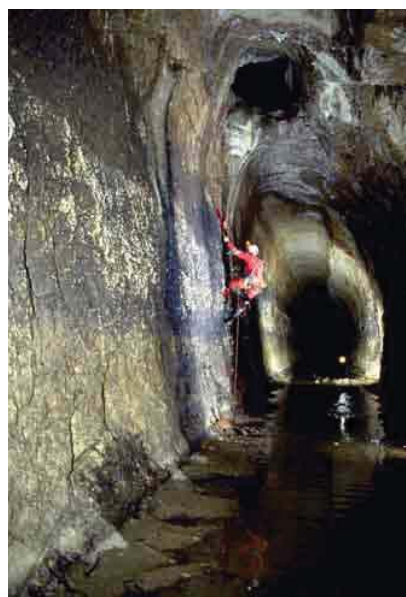
Figura 9: il collettore sotterraneo del Fucino nel tratto di intersezione con la Discenderia Salviano 1 (foto M. Vianelli).
