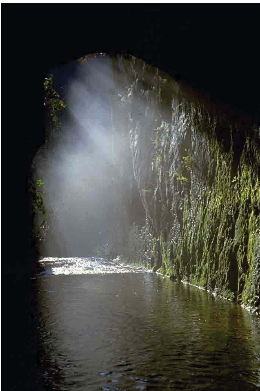
Figura 16: lo sbocco del collettore sotterraneo del Fucino nei pressi del salto sul fiume Liri (foto M. Vianelli).
