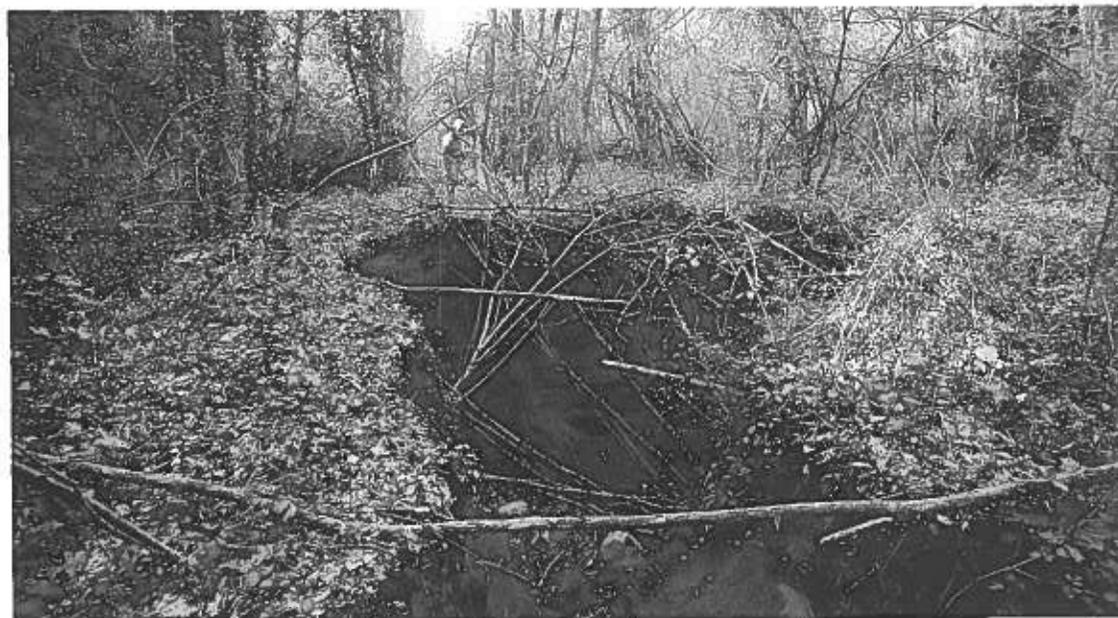
Foto 2.38 (sopra): una delle "doline" prodotte dal crollo dei pozzi di areazione dell'acquedotto del Malaffitto Alto - CA182LaRM - in località "la Cava" o "Canalone" (foto C. Germani).
