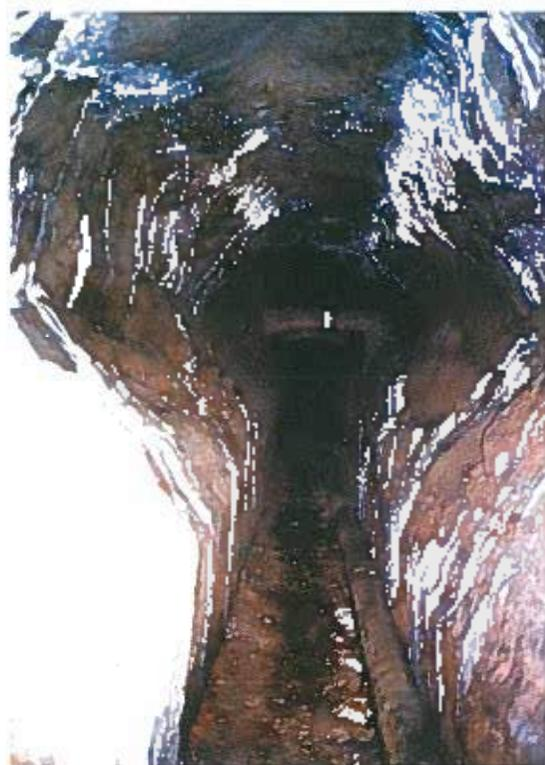
Foto 4.14: in prossimità del I bypass numerose colate calcifiche indicano la presenza di infiltrazioni di acqua. Si noti sullo sfondo uno degli archi di contenimento posti in opera nel 1929 per consolidare la struttura del condotto (foto V. Castellani).
