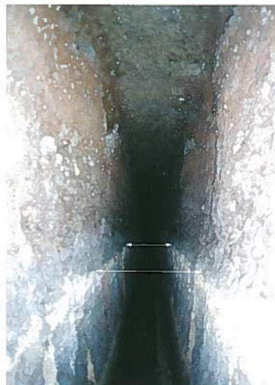
Foto 4.12: dopo l'incontro tra i condotti de l'Indio e della discenderia il condotto principale prosegue verso l'interno con andamento spiccatamente rettilineo. Le frecce mostrano le probabile base dello scavo originale (foto V. Castellari).
