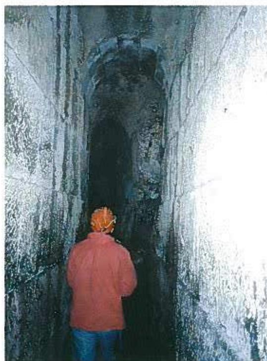
Foto 4.9. incile: termine della parte edificata in opera quadrata e inizio del cunicolo scavato nel vivo della roccia (foto V. Castellani)
