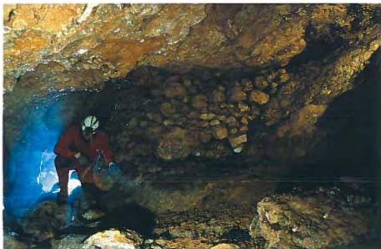
Foto 16: un muretto di sostegno nella miniera S. Patrizio (foto A. Danieli, Commissione Fotografica della Federazione Speleologica Veneta).
