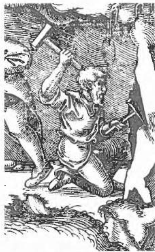
Fig. 3: particolare di un minatore intento nel lavoro di scavo con punta e mazza (da Agricola, 1563)
