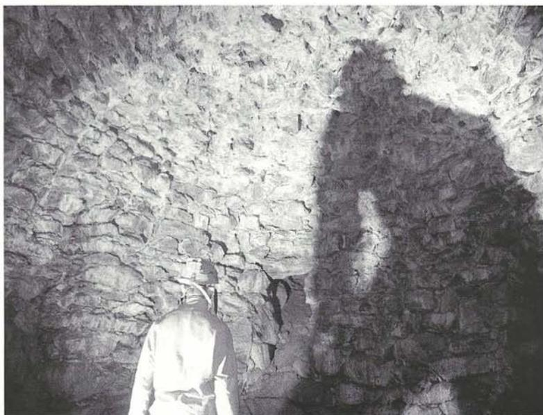
Foto 12: la camera a cupola della Ghiacciaia di Ferrania, completamente realizzata in pietre a secco (foto A. Verrini).
