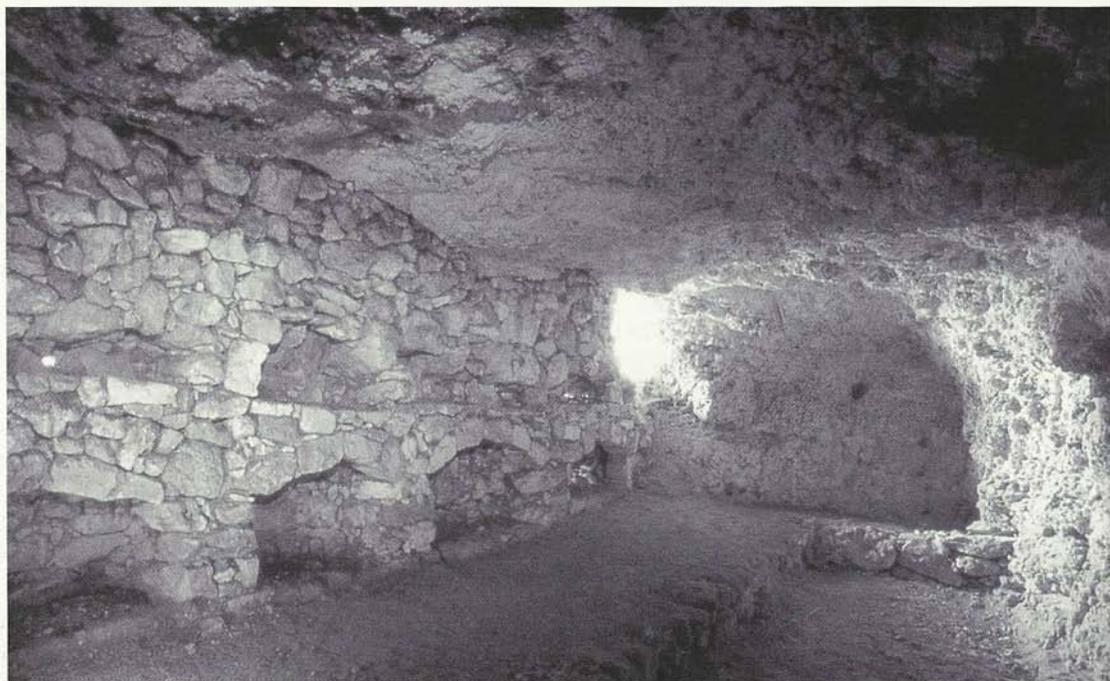
Foto 11: l'apiario superiore di Imgiebah era costituito da un unico grande "riparo sotto roccia", coperto da un ampio tetto di roccia naturale aggettante. Non essendo necessarie le suddivisioni ortogonali, le arnie erano alloggiata nelle nicchie ad arco ricavate direttamente nel muro longitudinale (foto M. Traverso).
