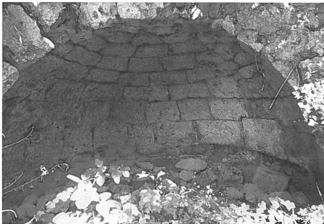
Foto 3: Castello d'Ischia, concamerazione coperta da volta emisferica, di probabile epoca romana (cavità CA 139.3 - foto G. Cappa).
