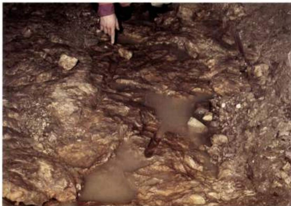
Foto 18: fori di martello perforatore rinvenuti nella miniera M1 (foto B Bocchino).
