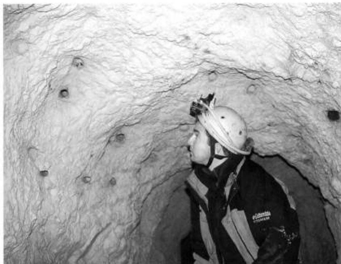
Foto 17: miniera di Fontana di Tasso - tratto di particolare concentrazione di fori di mina lungo le pareti in calcare della galleria (foto B. Bocchino).
