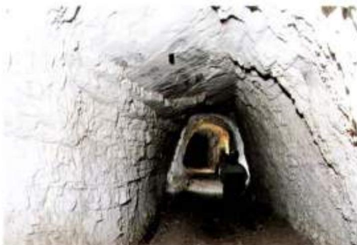
Foto 12: miniera di Fontana Tasso. Tratto di galleria del ramo alto, nei pressi dell'ingresso ostruito, scavato nei calcari, con tipica sezione trapezoidale. Sul tetto, corrispondente ad una superficie di strato, si possono notare anche alcune scritte (foto B. Bocchino).
