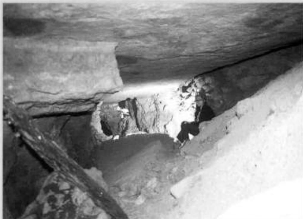
Foto 24: ramo terminale della miniera M3 in corrispondenza della faglia che ha gravemente alterato la stabilità della volta. Si noti a sinistra il puntello di sostegno divelto dai crolli (foto B. Bocchino).
