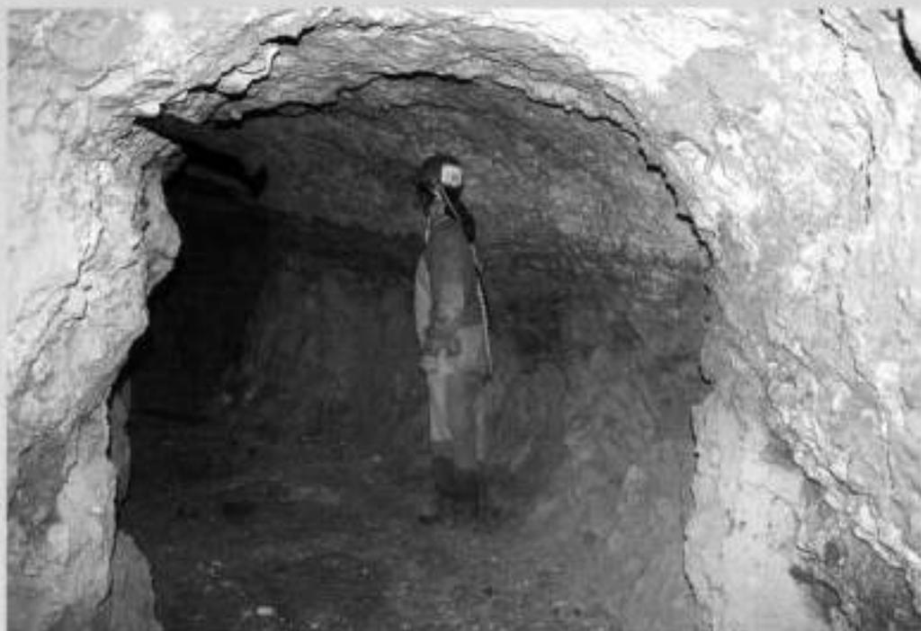
Foto 25: Tratto di galleria con sezione a volta lungo cui si osserva anche il contatto stratigrafico tra il livello di bauxite e le sovrastanti breccie calcaree (foto B. Bocchino).
