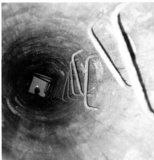
Foto 3: pozzo di accesso all'acquedotto (foto degli Autori).
