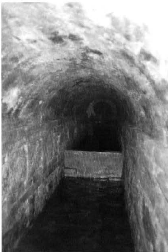
Foto 11: particolare di un setto trasversale di regimazione delle acque (foto degli Autori).
