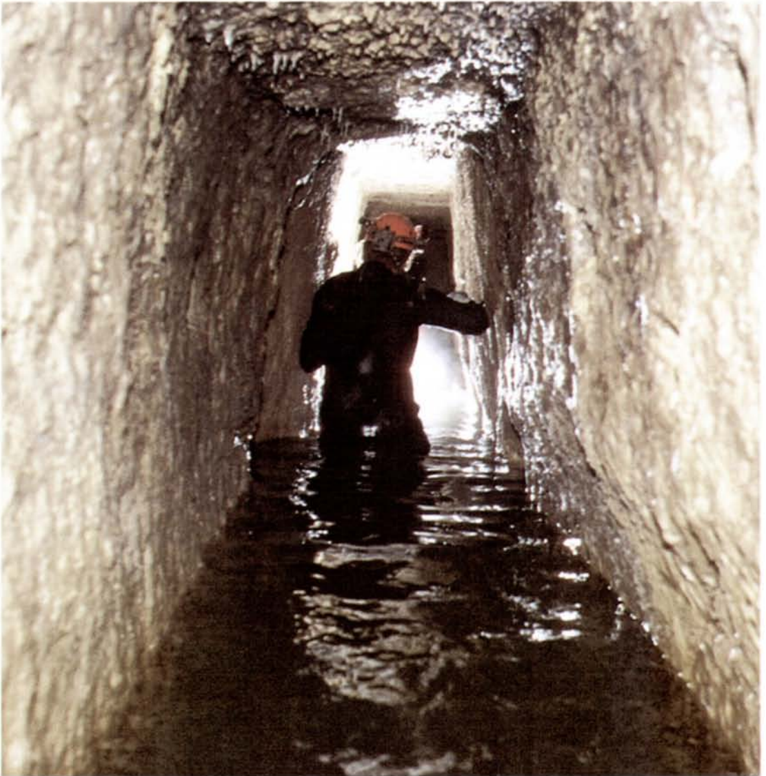
Foto 12: porzione originale dell'acquedotto, risalente al 1400 (foto degli Autori).
