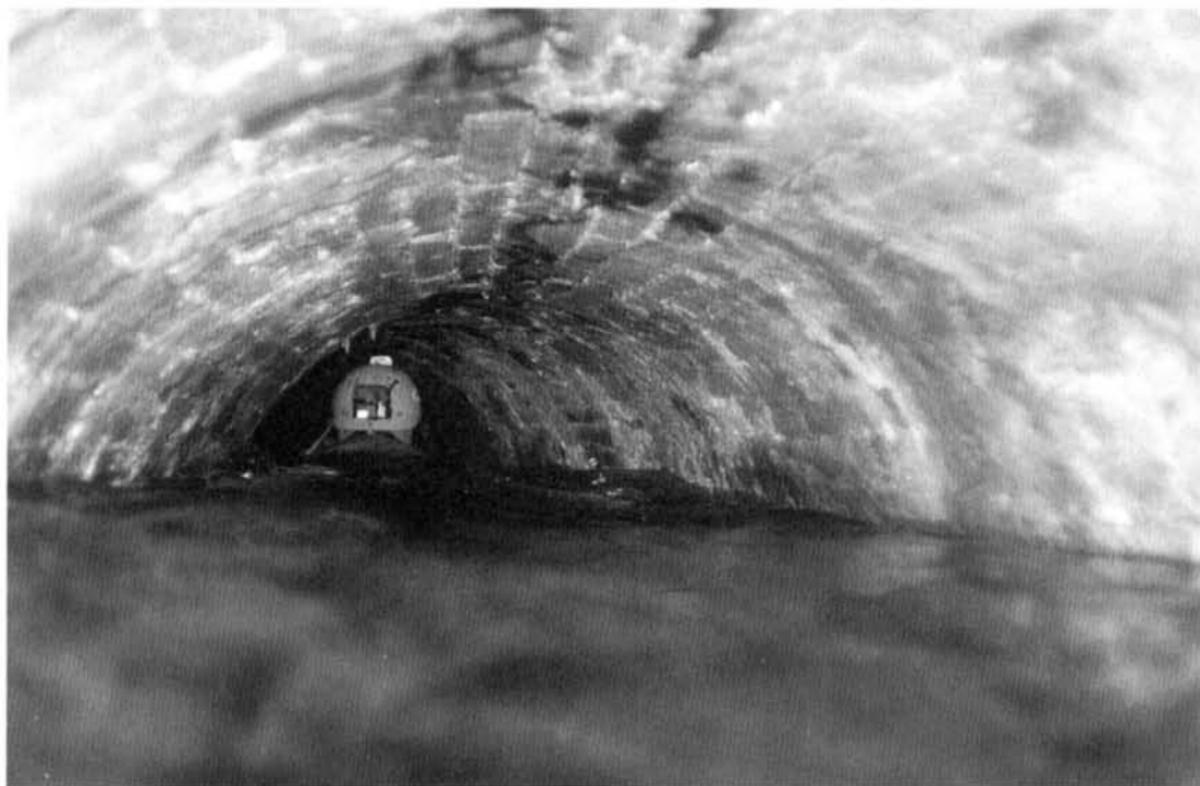
Foto 6: particolare della volta ottocentesca del cunicolo, con concrezioni calcaree e minute stalattiti (foto degli Autori).
