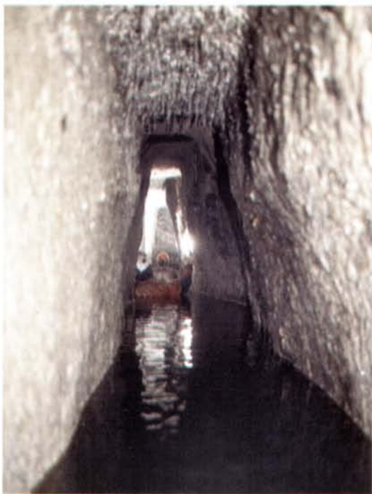
Foto 13: tratto di acquedotto risalente al 1400. Sono evidenti sulla volta alcune stalattiti (foto degli Autori).
