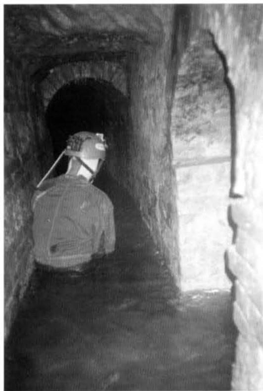
Foto 10: particolare della muratura ottocentesca caratterizzata dall'alternanza di pietra calcarea e due file di mattoni (foto degli Autori).
