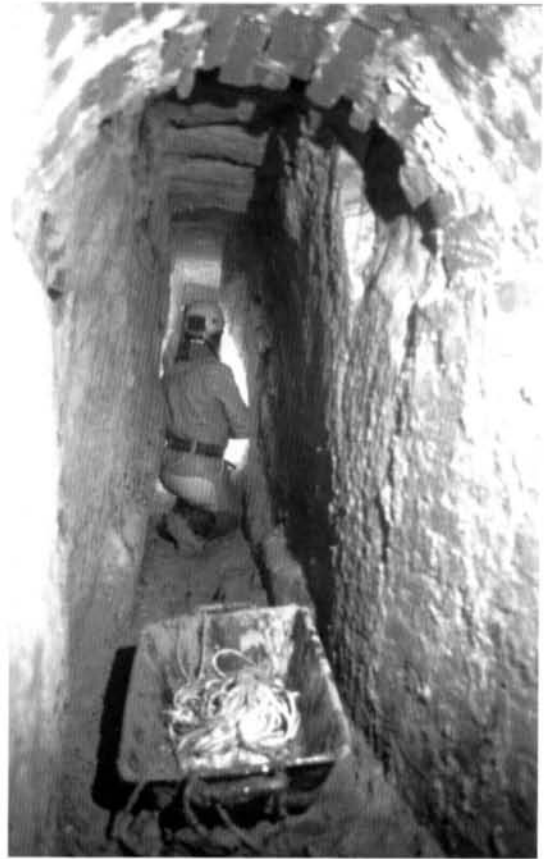
Foto 9: lavori di disostruzione all'interno della sorgente denominata "Trasversale" (foto degli Autori).
