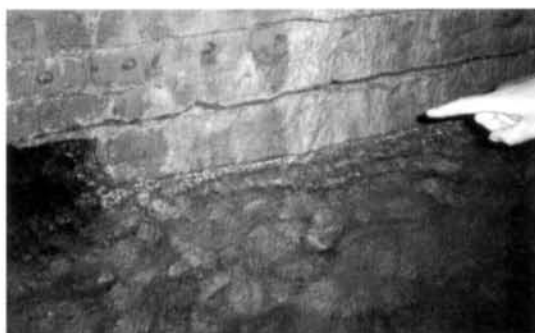
Foto 9: Fori drenanti inclusi nei mattoni; si noti la scarsa attività a causa delle occlusioni da concrezione (foto M. Chiesi).
