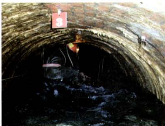
Foto 6: Corrimano con ancoraggio, cartellino di progressiva e linea telefonica (foto M. Chiesi).
