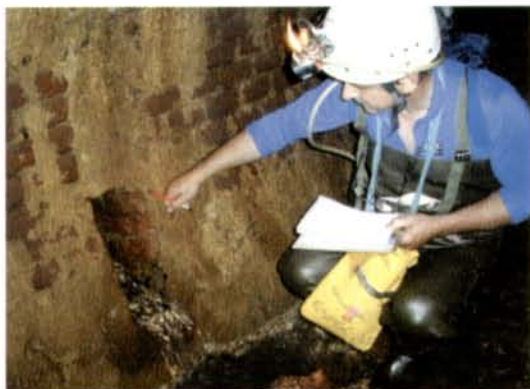
Foto 5: Finestra di drenaggio, parzialmente attiva, con evidenti segni di allargamento della sezione verso la galleria (foto M. Chiesi).
