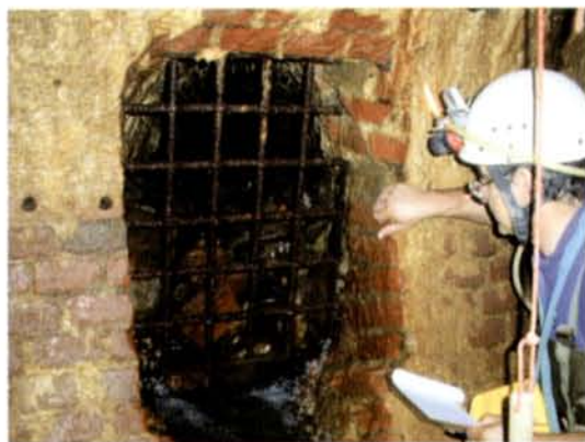
Foto 7: Innesto di una piccola condotta drenante posta verso il termine a monte: alcune evidenze farebbero supporre una sua costruzione successiva a quella della galleria principale (foto M. Chiesi).
