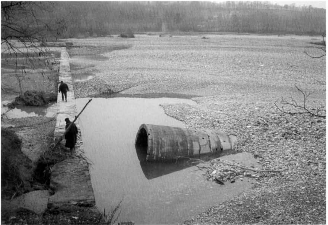
Foto 14: Il greto del Trebbia dopo le alluvioni del novembre 2000 - in primo piano la briglia sotto la quale si trova il traversante ed una delle torri in cemento, completamente divelte (foto M. Chiesi).
