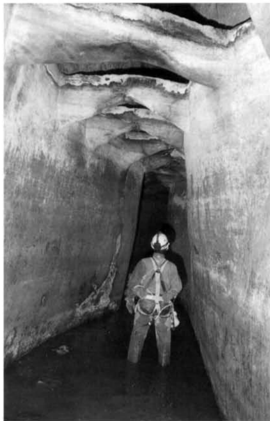
Foto 3: Cunicolo di accesso alla cisterna. Si notino, inoltre, i "ponticelli" per l'attraversamento e l'ispezione dello stesso (foto degli Autori).
