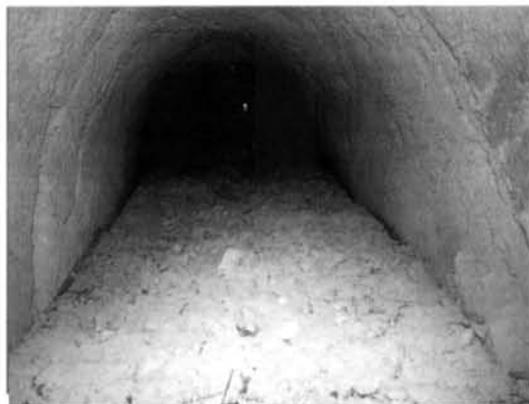
Foto 4: Ipogeo del Fico - in primo piano il materiale argilloso che ha invaso la cavità (foto degli Autori).
