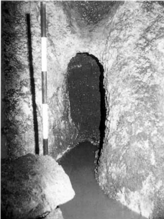
distinti bracci, raccordati mediante una concamerazione non definita, ma certamente sviluppati sotto l'alveo torrentizio, a sezione ogivale priva di qualsiasi foderatura e totalmente allagati. I necessari lavori di sistemazione hanno alterato parte della originaria conformazione.
