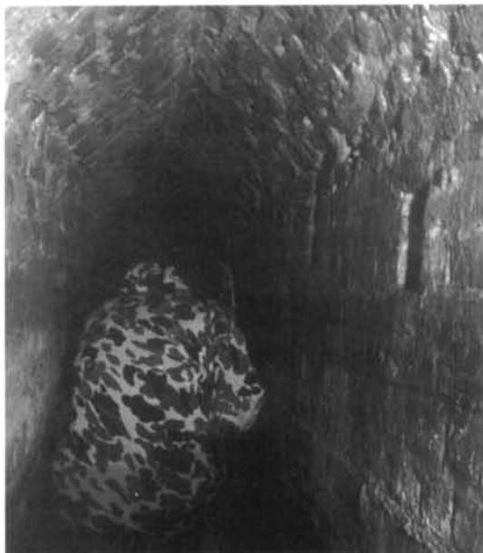
Foto 9: Fonte Fallera - particolare strutturale del cunicolo, con arco a tutto sesto e bocchetta di presa, in prossimità del punto 8 (foto P. Pasquini).
