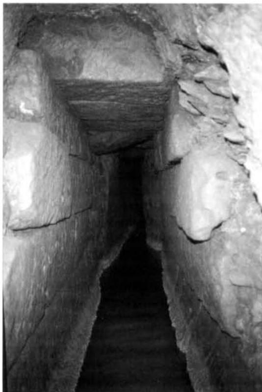
Foto 2 - In corrispondenza dell'attraversamento di tratti di roccia friabile il condotto di Palestrina appare talora protetto da una pesante struttura di massi in opera quadrata (foto V. Castellani).
