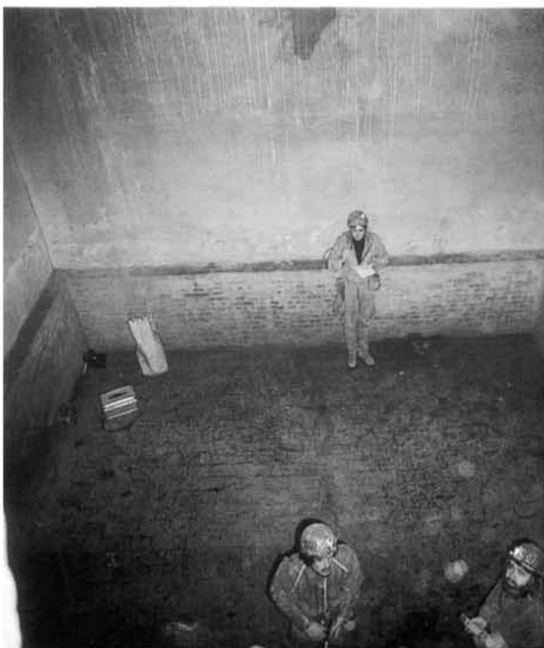
Foto 2 - La grande cisterna (foto P. Forti).
