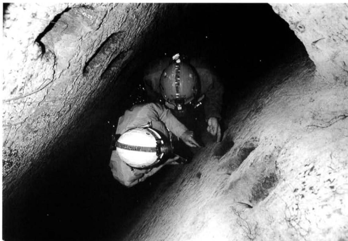
Foto 4 - Gravina di Puglia: pozzo di ispezione dell'acquedotto sotterraneo. I gradini scavati nel tufo (pedarole) hanno notevoli analogie con quelle rilevate nei pozzi degli insediamenti sotterranei della Cappadocia (Foto R. Bixio)
