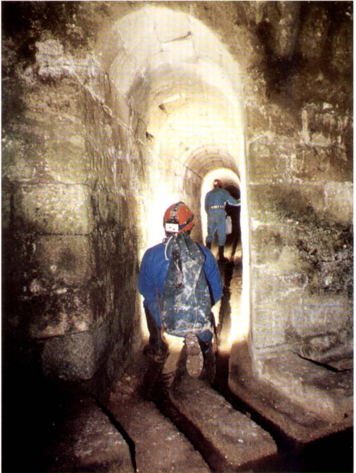
Foto 3 - Gravina di Puglia: inizio del cunicolo sotterraneo dell'acquedotto. Si notano le due canalette per la manutenzione del condotto (Foto R. Bixio)
