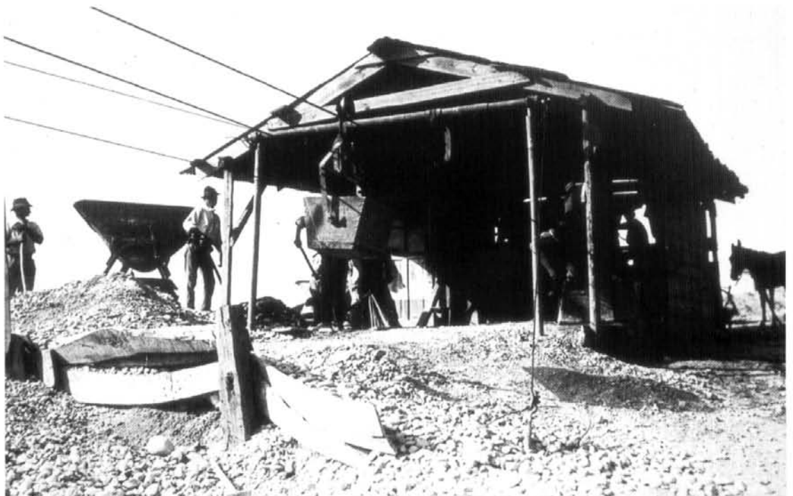
Foto 2 - Per trasportare più agevolmente il materiale necessario alla costruzione delle gallerie cannoniere di Monte Fortin, venne realizzata una teleferica in posizione protetta. Fotografia scattata presumibilmente nell'estate del 1915 (Archivio Musei Provinciali - Gorizia)
