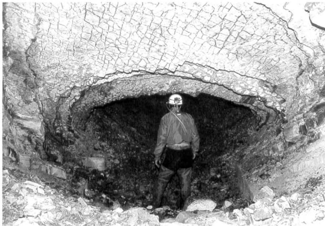
Foto 4 - Un tratto non blindato della galleria principale. I lavori di scavo del forte hanno messo in piena evidenza le stratificazioni del flysh, creando un ambiente di particolare suggestione (Foto Marco Meneghini - C.R.C. "Seppenhofen" Gorizia)
