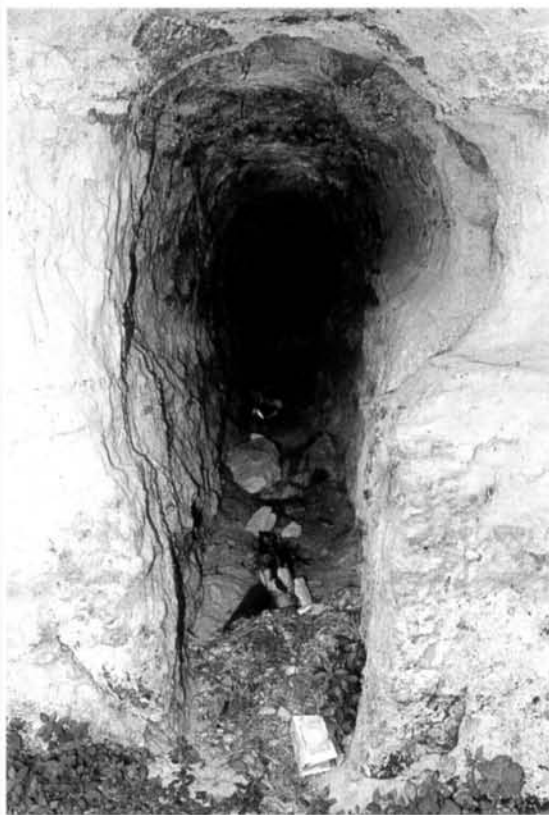
Foto 1 - Acquedotto di S. Liberato: vista della galleria tagliata da uno sbancamento (Foto Mauro Nori)
