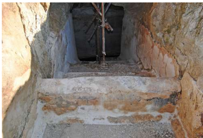
Fig. 8: edging of separation by cocchiopesto. Fig. 8: cordolo di separazione in cocciopesto.
