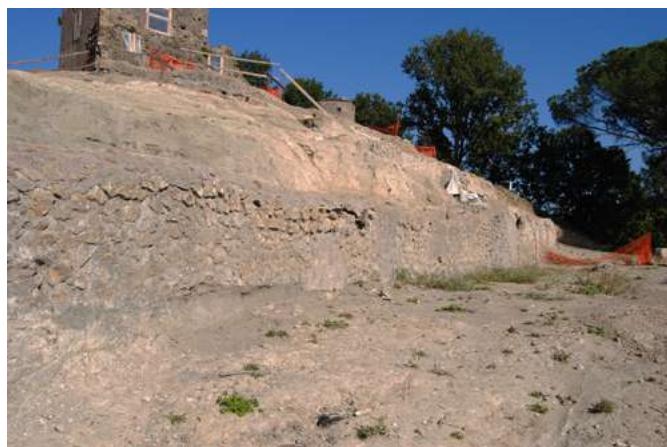
Fig. 5: wall substructure in opera incerta. Fig. 5: muro di sostruzione in opera incerta.
