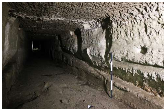
Fig. 5: draining rims cut into the side walls (photo V. Puggini). Fig. 5: canaline di drenaggio scavate nelle pareti laterali (foto V. Puggini).
