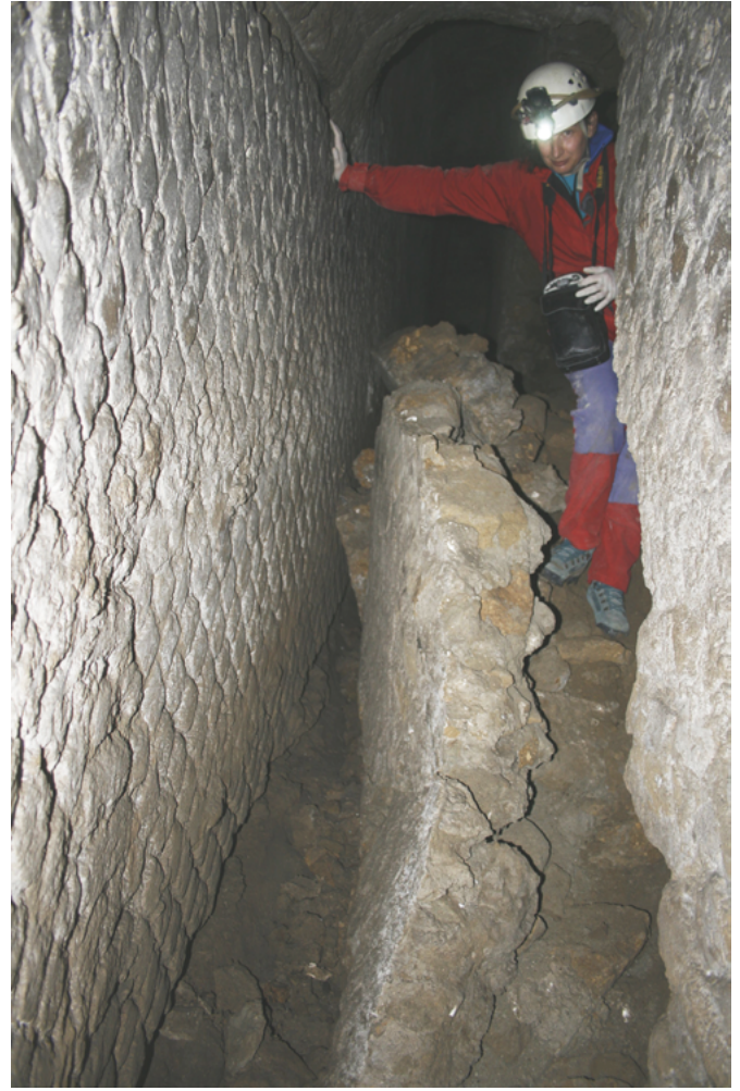
Fig. 6: wall masonry collapse at point J (photo B. Bocchino). Fig. 6: distacco parietale al punto J (foto B. Bocchino).
