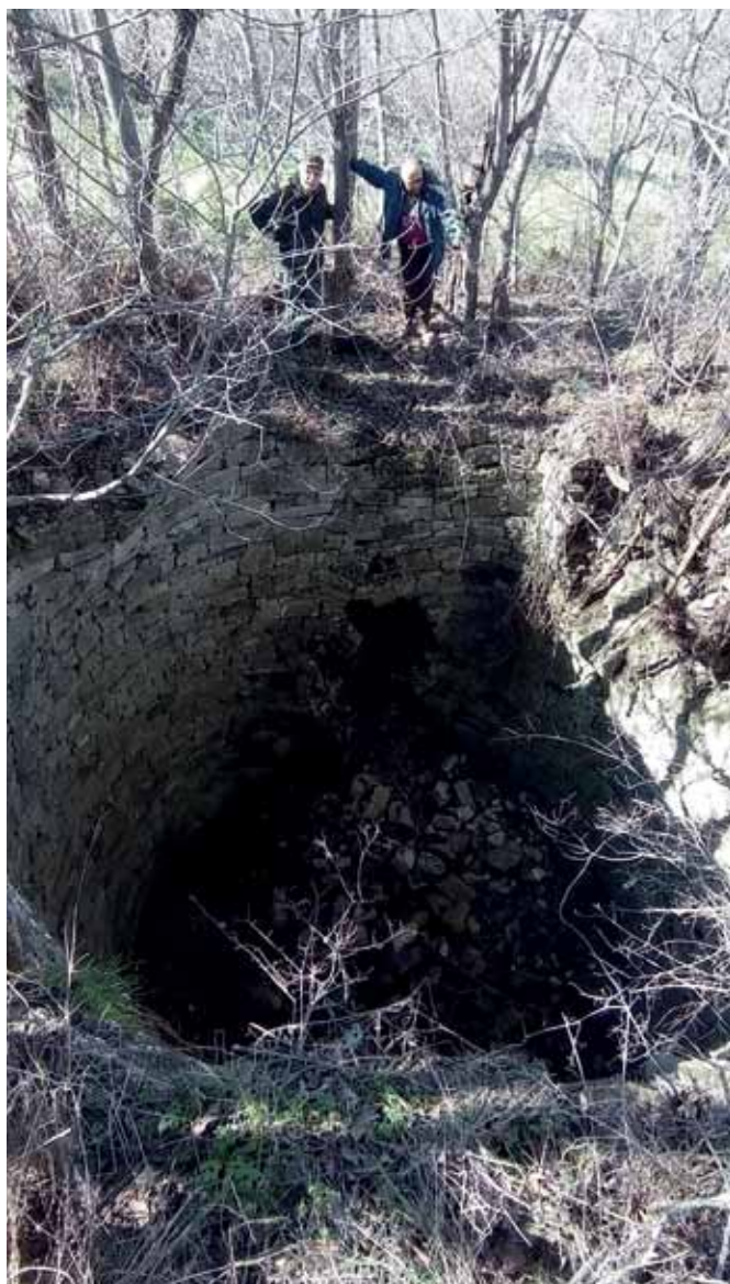
Fig. 17a – Neviera della tipologia in buca nel terreno con pareti rivestite / Lucito (CB) (tipologia A9d) (foto M. Mancini).
