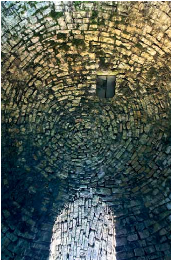
Fig. 1 – Dettaglio delle tecniche costruttive della volta e dell'ingresso di una nevieria in agro di Bonefro (CB / Molise) (foto N. Paolantonio).
