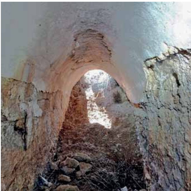
Fig. 8 – Tratto dello speco del Marcio nei pressi del Punto B, visto in direzione sud. Si noti la copertura a volta (foto A. Boccone).
