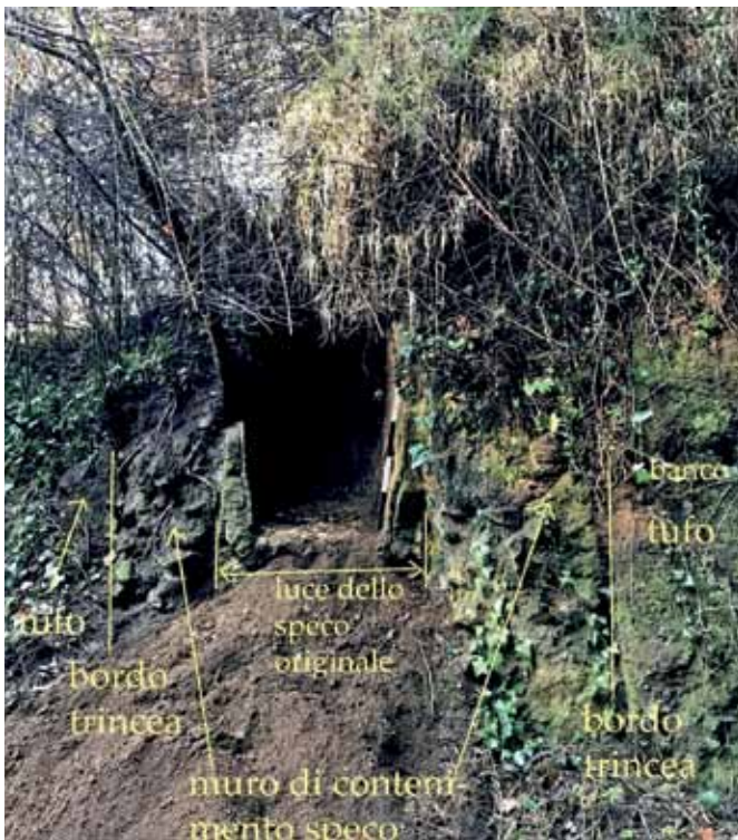
Fig. 18 – La struttura dello speco nel Punto D (foto ed elaborazione grafica A. Schatzmann).
