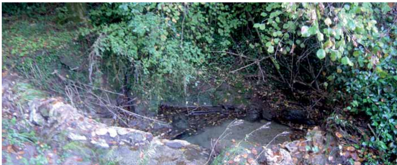
Fig. 15 – Resti del canale di derivazione per incanalare l’acqua ad uso mulino (foto B. Leoni).
