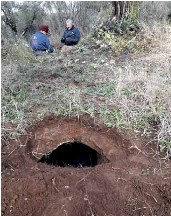
Fig. 7 – Punto B: liberato dai detriti del crollo della volta dello speco consente l'accesso all'acquedotto verso nord (foto G. Cammilletti).
