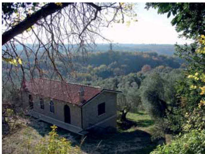
Fig. 5 – Il nuovo edificio costruito ad inizio secolo sulla Cantina del Casale, cioè su un tratto dell’acquedotto Marcio, visto dal Casale stesso (foto B. Leoni).
