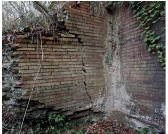
Fig. 14 – I resti della struttura del ponte su cui il Claudio attraversava il Fosso dopo esser passato sotto al Ponte di S. Antonio (foto S. Troisi).
