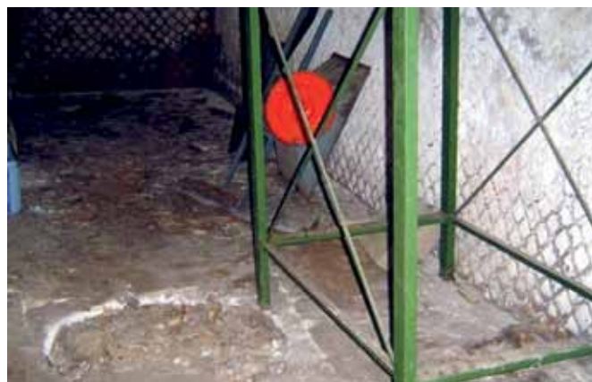
Fig. 4 – Locale sito al piano interrato del Casale dell'Acqua Raminga (foto B. Leoni).
