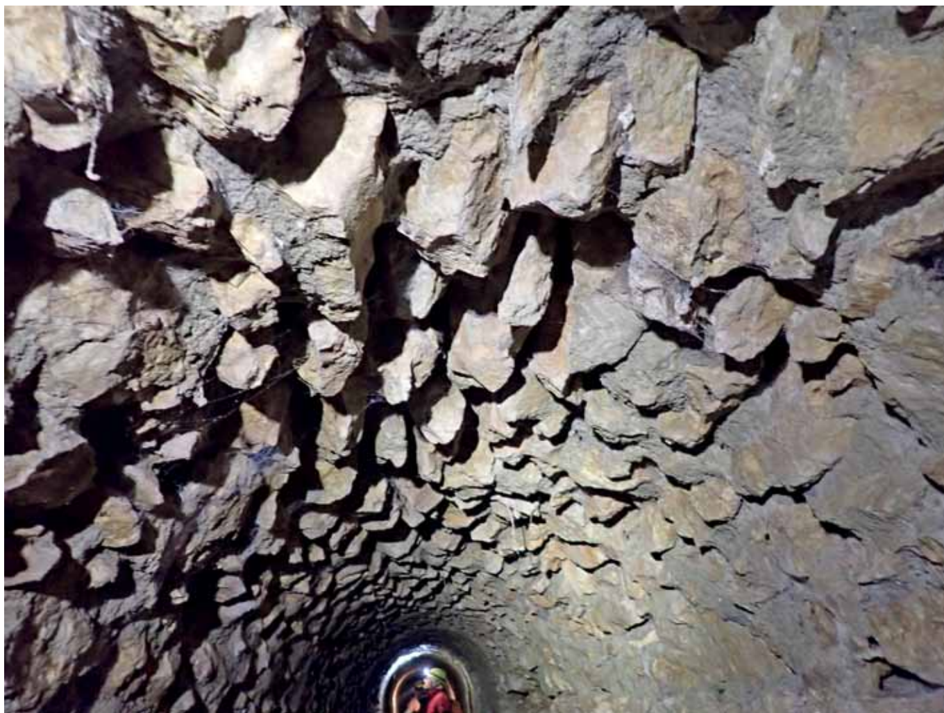
Fig. 11 – La prima parte del tunnel (foto S. Gambari).
