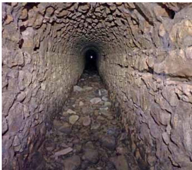
Fig. 28 – La prima parte del tunnel. (foto S. Gambari). Fig. 28 – The first part of the tunnel (photo S. Gambari).
