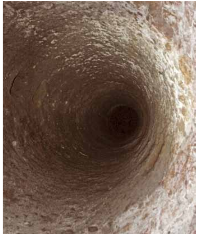
Fig. 20 (in alto), 21 (in basso) – Vista del pozzo P2 scavato all'interno della seconda nicchia quadrangolare sul fianco della parete settentrionale della galleria di carriaggio di Colle Selva. Sul fondo è stato realizzato il tratto del bypass ipogeo dell'acquedotto dell'Aqua Marcia. Particolare del cilindro del pozzo profondo m 11,60, con le nicchie (pedarole) contrapposte utilizzate per la discesa e la risalita degli operai (Galliciano nel Lazio - Roma).
