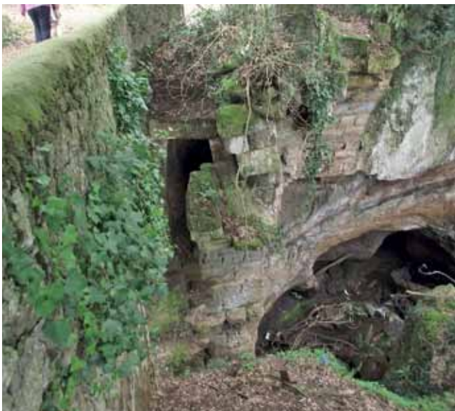
Fig. 5 – Vista dei resti dello speco, in opera quadrata di tufo, dell'acquedotto dell'Anio Vetus di Ponte Pischero, crollato all'interno del Fosso Caipoli con accanto il ponte carrabile ottocentesco realizzato utilizzando le spalle del più ampio ponte romano; Galliciano nel Lazio - Roma.
