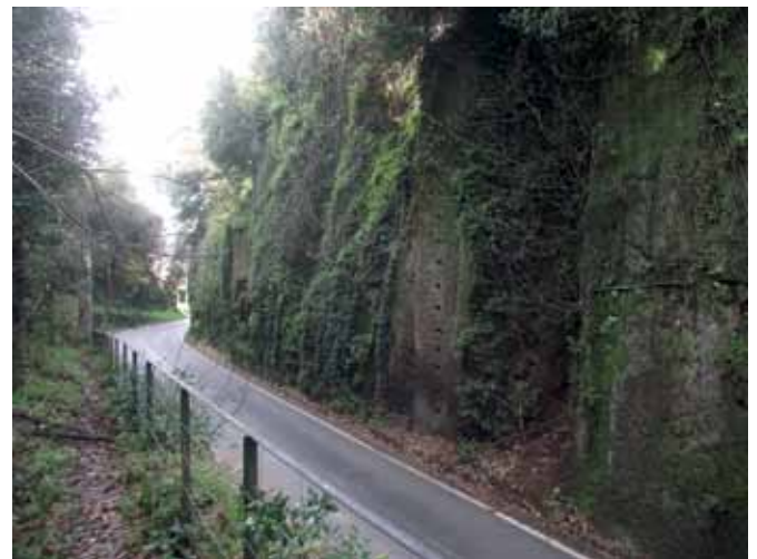
Fig. 25 – Vista della tagliata stradale dell'antica via Prenestina in località S. Maria di Cavamonte. A sinistra, parte del basolato conservato; sulla parete opposta uno dei due pozzi antichi sezionati dall'allargamento ed approfondimento moderno della carreggiata e, probabilmente, appartenuto all' Aqua Marcia (Galliciano nel Lazio - Roma).
