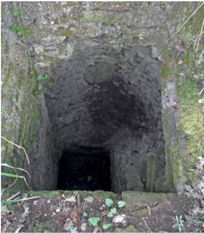
Fig. 14 – Vista dei resti del pozzo P6, le pareti sono rivestite di tufelli rettangolari alti cm 10/12 e lunghi cm 20/35. Le due pareti a Sud e Ovest sono parzialmente crollate.
