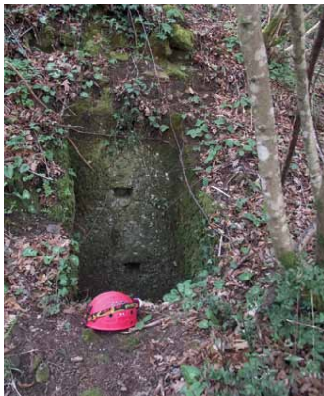
Fig. 12 – Vista dei resti quadrangolari del pozzo (P2), distante circa m 30 dal pozzo P1, le cui pareti sono realizzate sul fianco della collina in opera reticolata di tufo.
