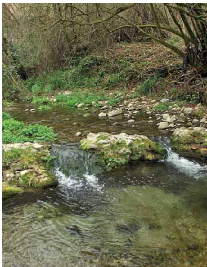
Fig. 8 – Vista dei resti della briglia edificata all'interno del fosso della Valle della Mola, parzialmente erosa e lesionata, sita poco più a monte di Ponte San Pietro in agro di San Gregorio da Sassola - Roma.
