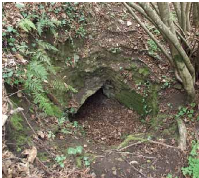
Fig. 11 – Vista dei resti del pozzo P1, verosimilmente d'ispezione e di dissipazione dell'elevata velocità delle acque, disposto a circa m 3 dall'ultimo tratto inclinato di muro del ponte della Mola dell'acquedotto dell' Anio Vetus .
