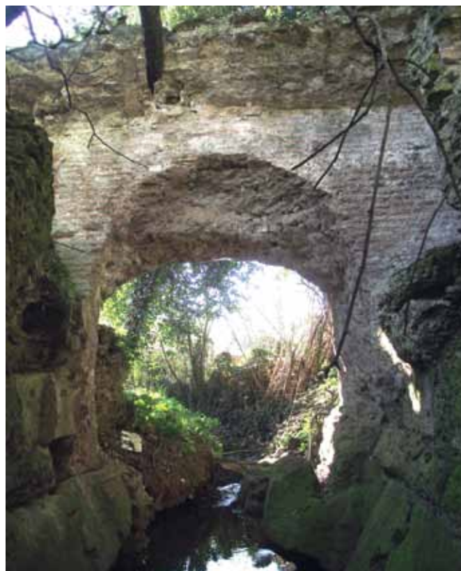
Fig. 27 – Vista della parete interna orientale dello specus dell'acquedotto dell' Anio Novus , in località Val Pantano presso il casolare denominato "Fienile". In basso i resti delle spalle del piccolo ponte in opera quadrata di tufo collassato all'interno del rio del Fosso di Val Pantano (Galliciano nel Lazio - Roma).
