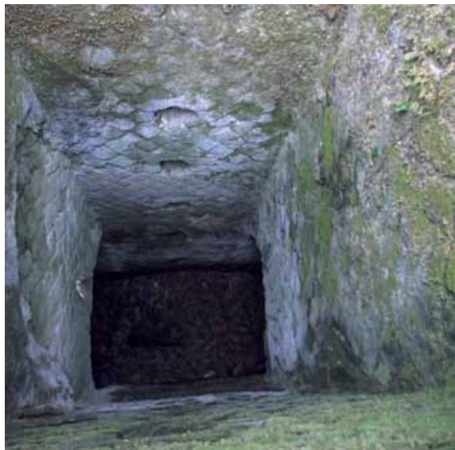
Fig. 13 – Vista interna del pozzo P2 con le pedarole incassate sulle due pareti contrapposte in opera reticolata di tufo e sul fondo il cunicolo dello speco dell'acquedotto dell' Anio Vetus .
