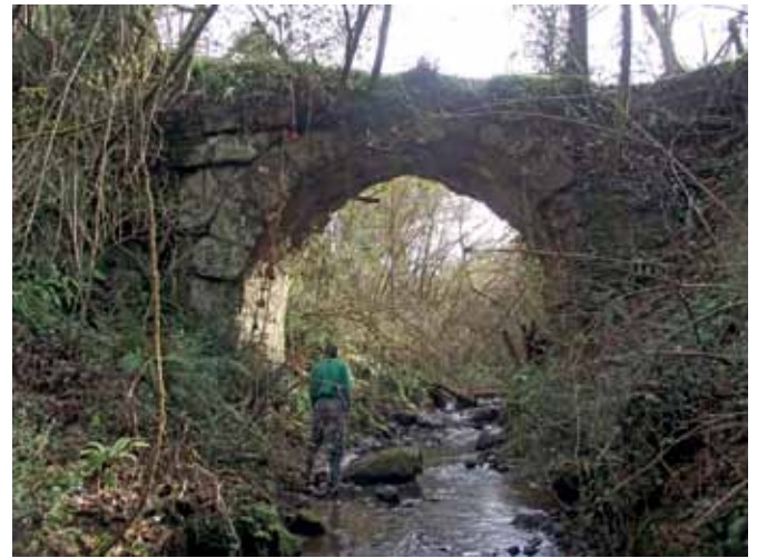
Fig. 24 – Vista di Ponte Bulica dell'acquedotto dell' Aqua Marcia , edificato in opera quadrata di tufo all'interno del Fosso di Collafri (Galliciano nel Lazio - Roma).
