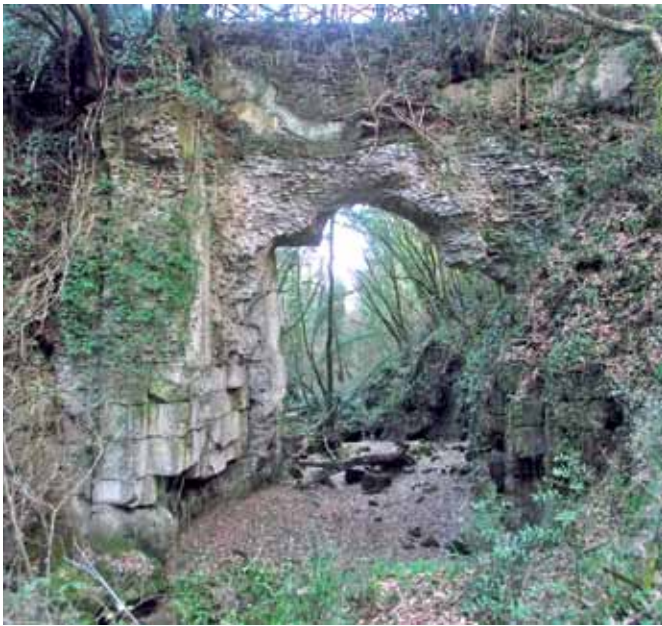
Fig. 4 – Vista dei resti di Ponte Taulella, ponte-acquedotto dell'Anio Vetus, edificato all'interno del fosso Rio Secco in opera quadrata di tufo con restauri e rinforzi laterizi d'età imperiale; Galliciano nel Lazio - Roma.
