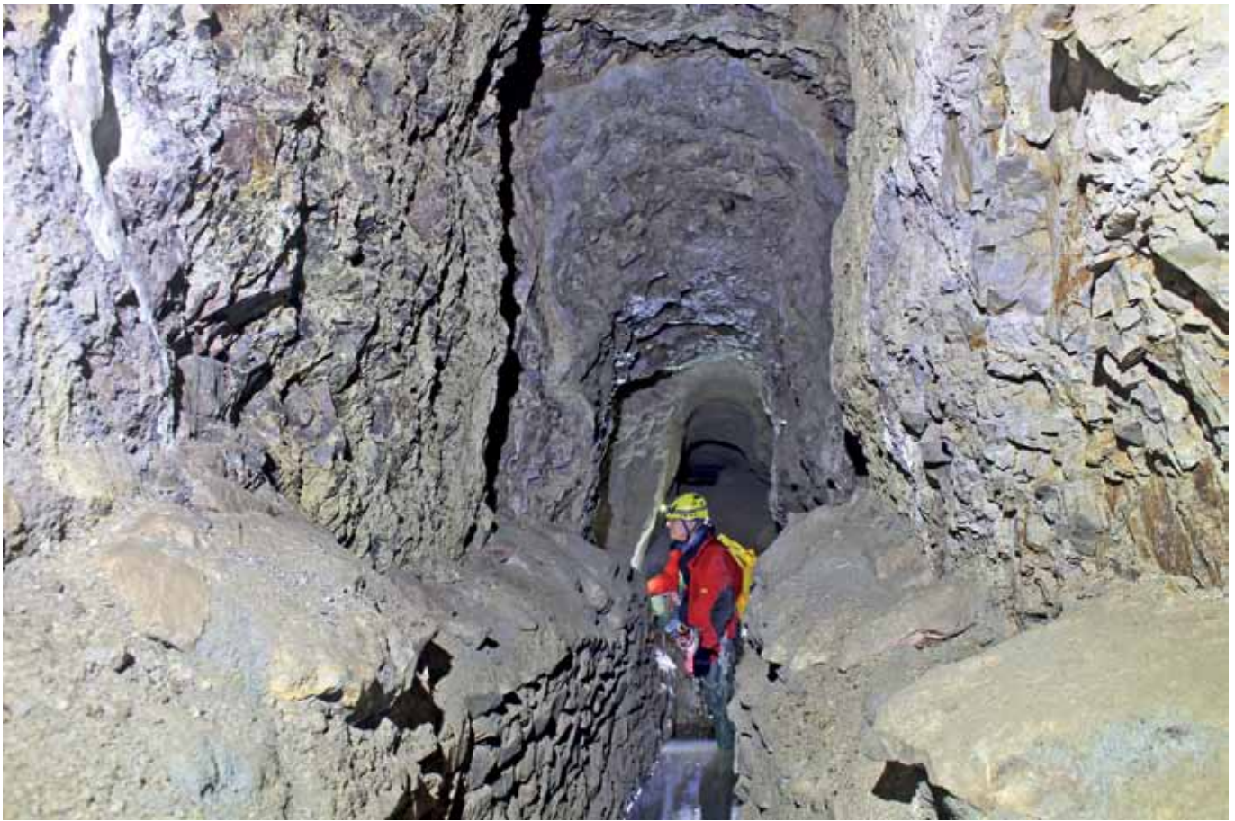
Fig. 18 – Buso della Casara: scorcio del settore orientale del collettore, nella sua parte terminale. Sono visibili i muretti di contenimento e protezione del condotto idrico (foto M. Romano).
