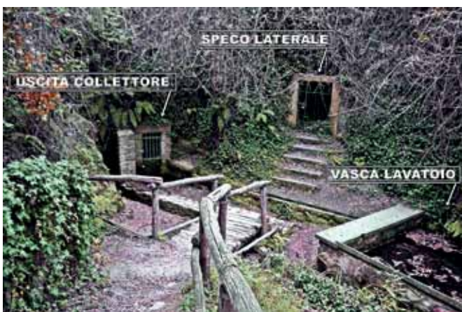
Fig. 14 – Buso della Casara: uscita del collettore (a sinistra) e l’ingresso dello speco laterale cieco (a destra); a latere la vasca lavatoio in uso nel secolo scorso e restaurata nel 2006 (foto M. Romano).
