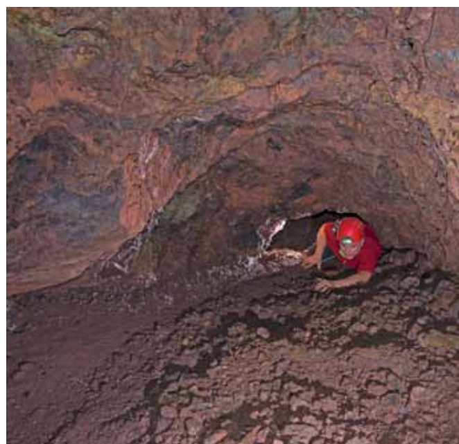
Fig. 18 – Tratto collassato della Galleria N° 5 (foto L. Tinagli).
