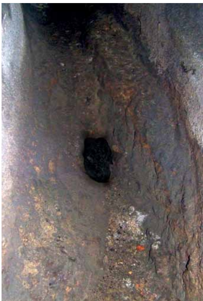
Fig. 6 – Cavità di vico San Nicola a Nilo. Fori nel pavimento del cunicolo n° 5 del rilievo topografico che rivelano la presenza di ulteriori cavità sottostanti (foto R. Varriale).
